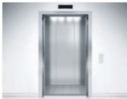
a) La cabine d'un ascenseur
